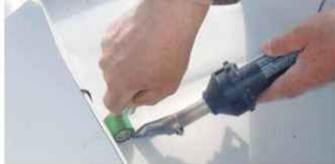
HOT JET S je vhodný i pro svařování v obtížně přístupných místech.
