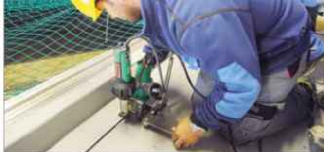
Pomocný vozík dodá přístroj větší stabilitu.
