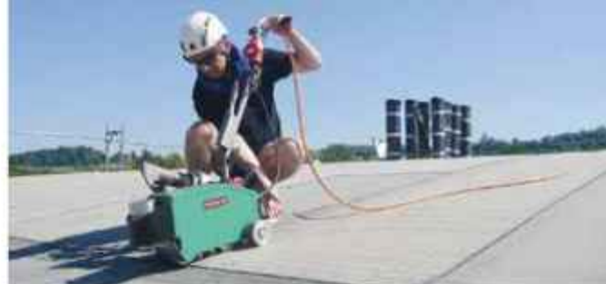
Bezplamenné svařování modifikovaného bitumenu - BITUMAT B2.
