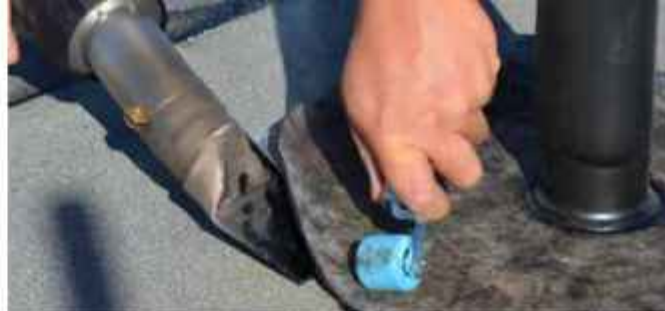
ELECTRON ST svařování bitumenových pásů.
