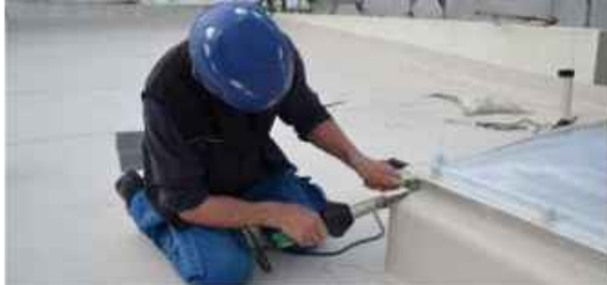
Detailní práce na střešním okně.
