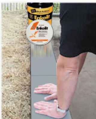
Oplechování rovnoměrně přitlačit
