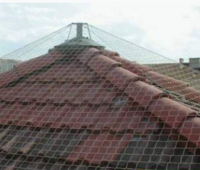
Plošné ošetření střechy sítí S051
